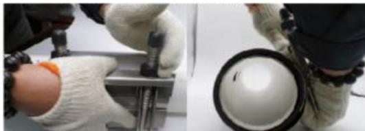
Paso 3 Monte la abrazadera alrededor del tubo colocando la placa de bloqueo sobre las orejetas de alineación y apretando a mano las tuercas para mantenerla en su lugar.
